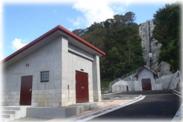
○龍門滝発電所(鹿児島)
