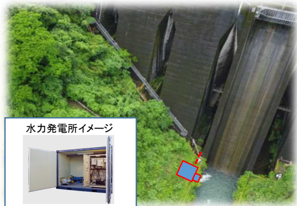
○諸塚ダム維持流量発電所(宮崎): 建設中
